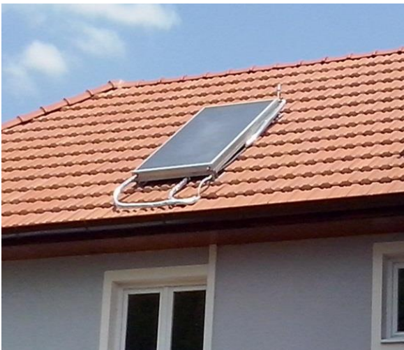
Slika 1. Montiran solarni kolektor
